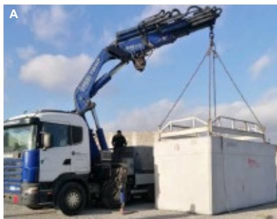
Fig. A: movimentazione con bilancino - Fig. B: movimentazione con cavi o cinghie.
