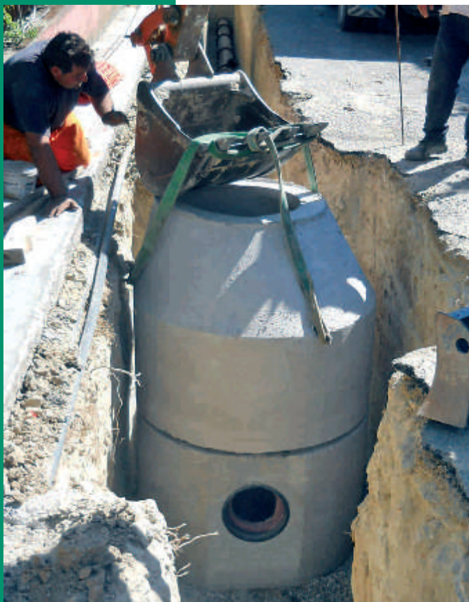
ASSEMBLAGGIO DI POZZETTI CIRCOLARI PER ACQUE BIANCHE. Comune di Cagliari, località Barracca Manna, Cagliari-Pirri.
