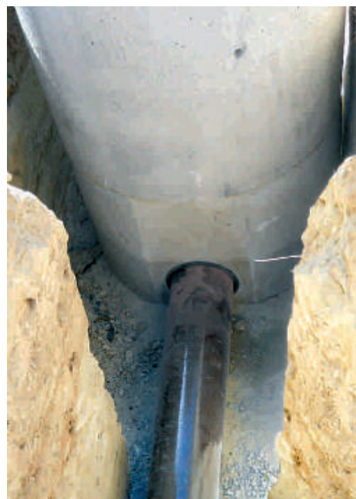
ASSEMBLAGGIO DI POZZETTI CIRCOLARI PER ACQUE BIANCHE. Comune di Cagliari, località Barracca Manna, Cagliari-Pirri.
