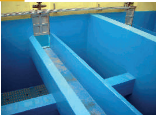
PIASTRE FILTRANTI PER LA COSTRUZIONE DEL NUOVO IMPIANTO DI POTABILIZZAZIONE. Comune di Sanluri - VS.
